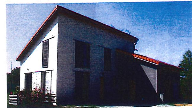
Toitures mono pente sur les constructions principales
